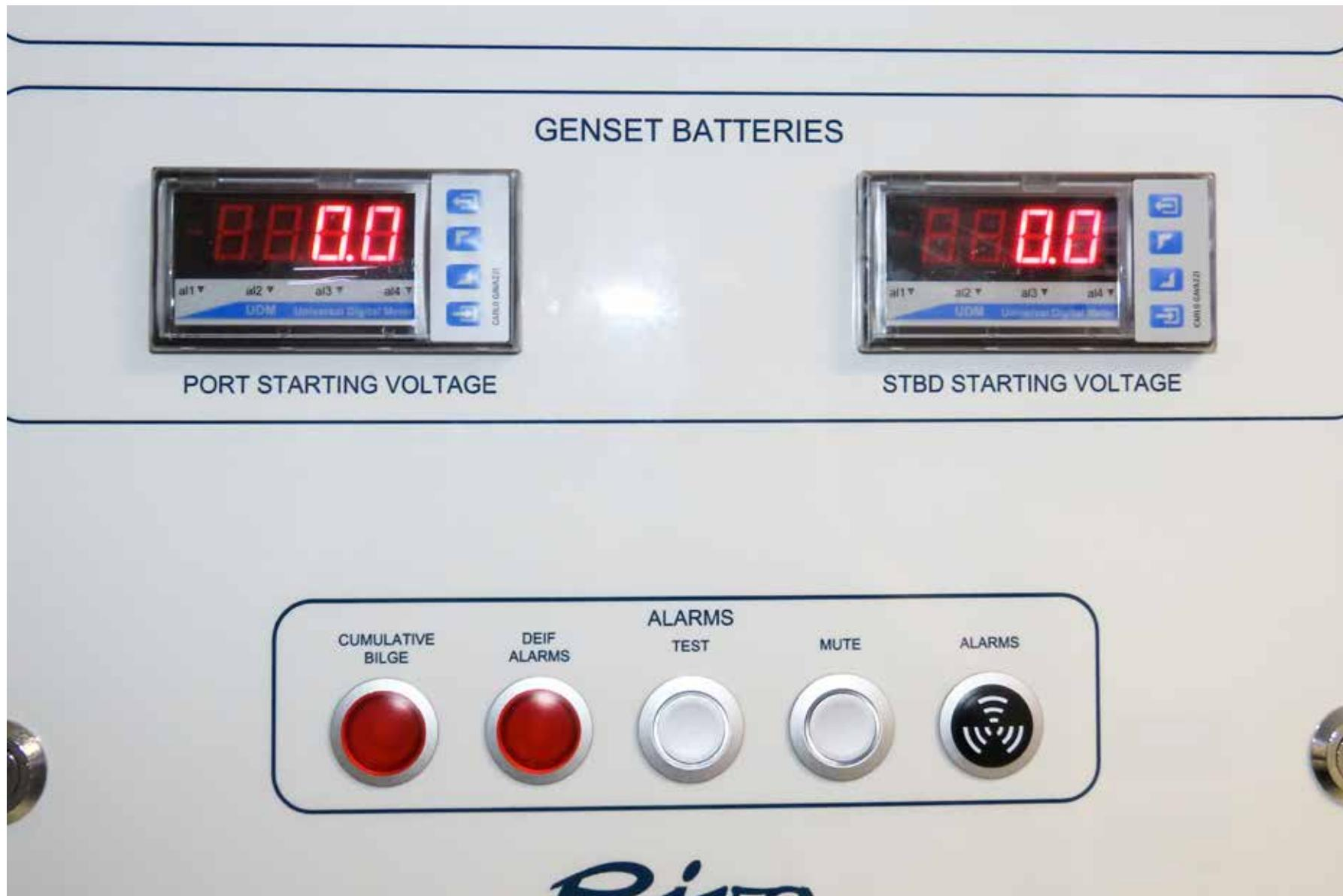
B. Pulsanti comando utenze 400 / 230 VAC e strumenti di misurazione tensione elettrica:
